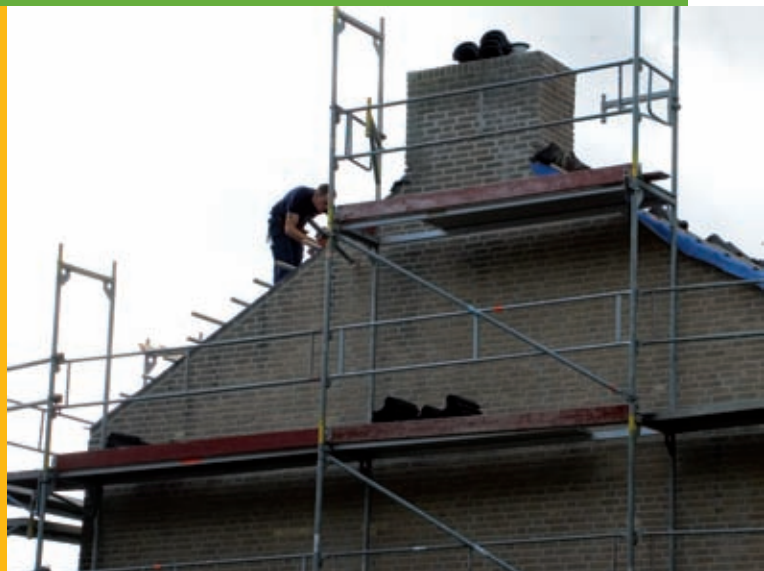
Het isoleren van de daken levert een finke besparing op
